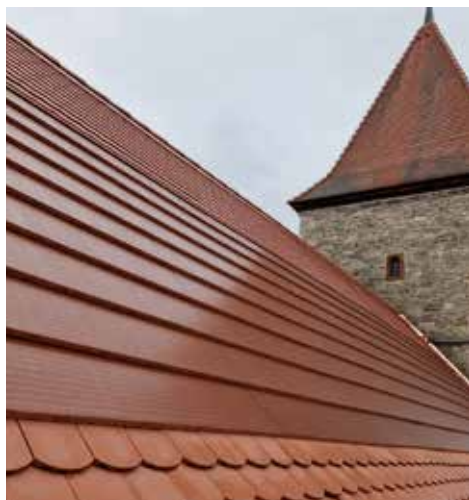
Beispiel: Solarziegel mit Biberschwanzdeckung (einsehbarer Bereich / Denkmal)
