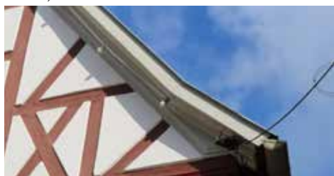
Ortgang, schmales Stirnbrett mit Abdeckblech
