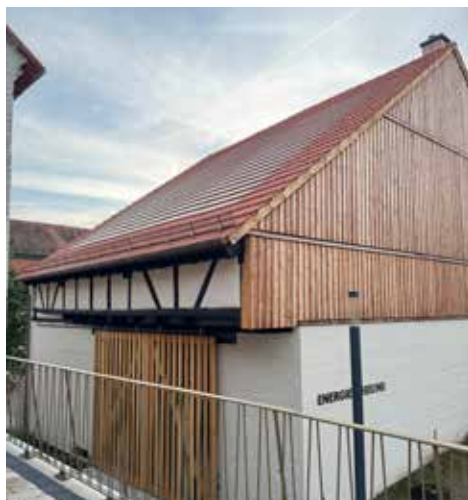
Beispiel: Solarziegel mit Rinnenfalzziegeln (einsehbarer Bereich / Denkmal)
