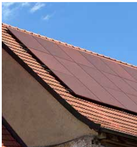
Beispiel: farblich angepasste PV-Module (nicht einsehbarer Bereich)
